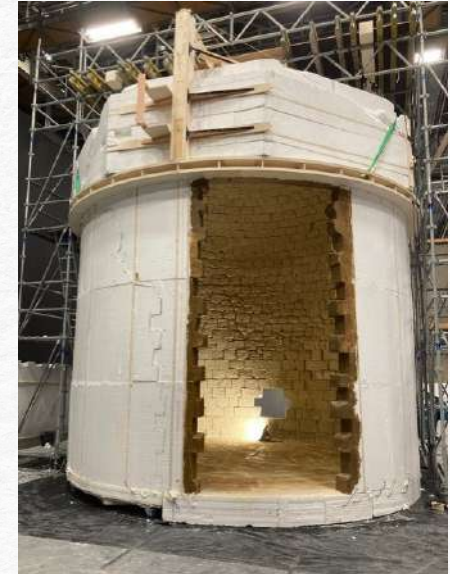
Cachot en polystyrène armé de bois et muni de plâtre projeté pour le Comte de Monté Cristo d'Alexandre de La Patellière et Matthieu Delaporte. Chef décorateur, Stéphane Taillason, production : Pathé Films, 2024. © Gilles Bontemps
