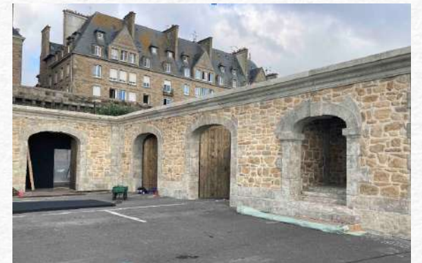
Façade en staff et polystyrène matrière pour la série Benjamin Franklin . Chef déco Dan Weil, production : Apple TV, 2024. © Gilles Bontemps
